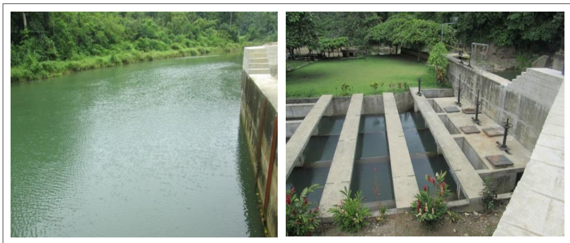
Figura 12. Captación de agua de uso doméstico La Avanzada Fuente: Equipo Consultor
