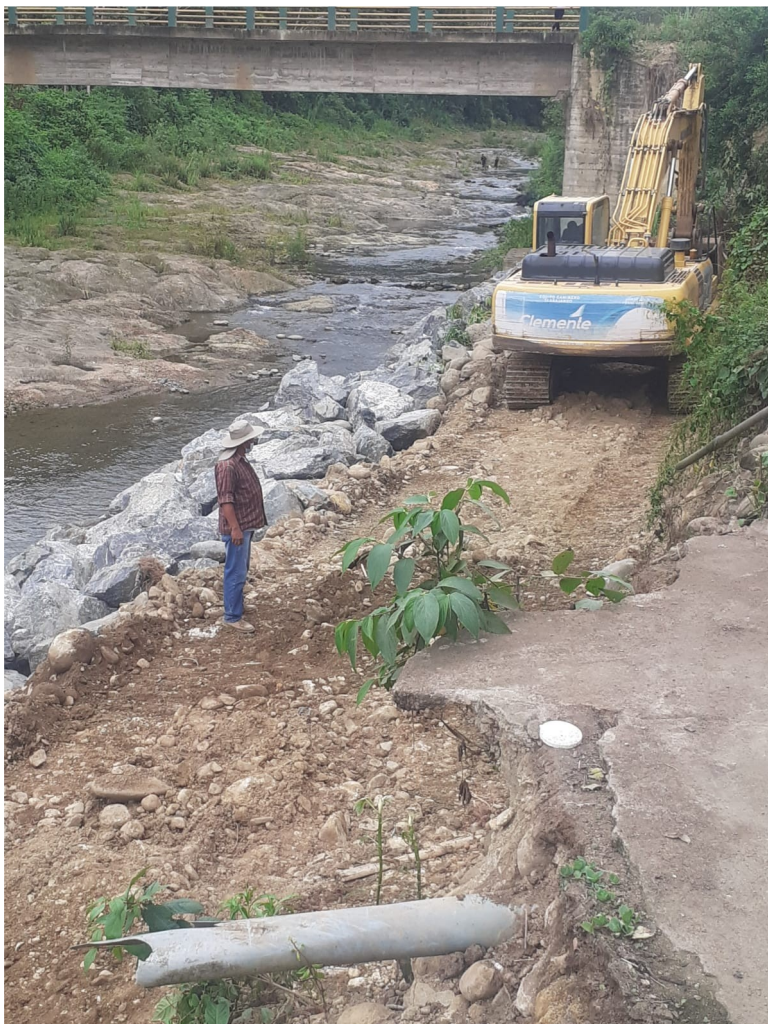
Trabajos en el muro de escollera
