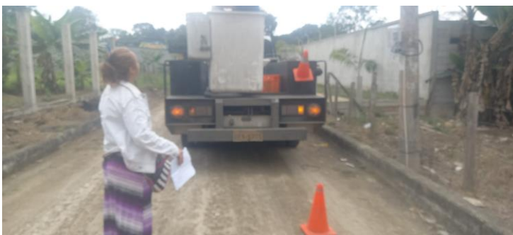
Coordinando con los técnicos de CNEL para la reparación de iluminarias quemadas en los sitios y Ciudadela de la parroquia.
