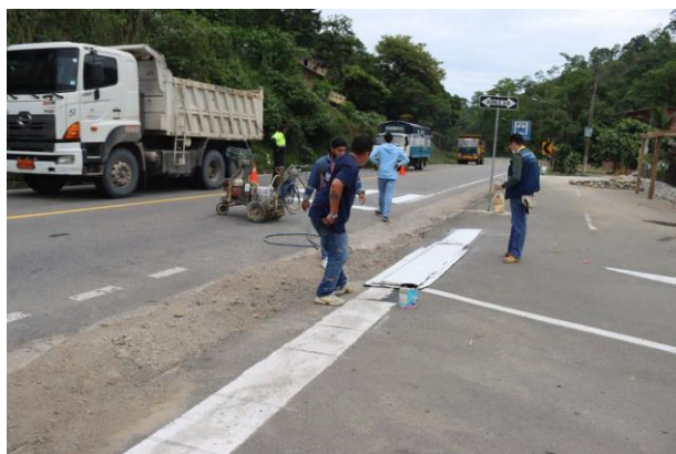
Fiscalización a señalización en la carretera del sitio limón playas y el vado.
