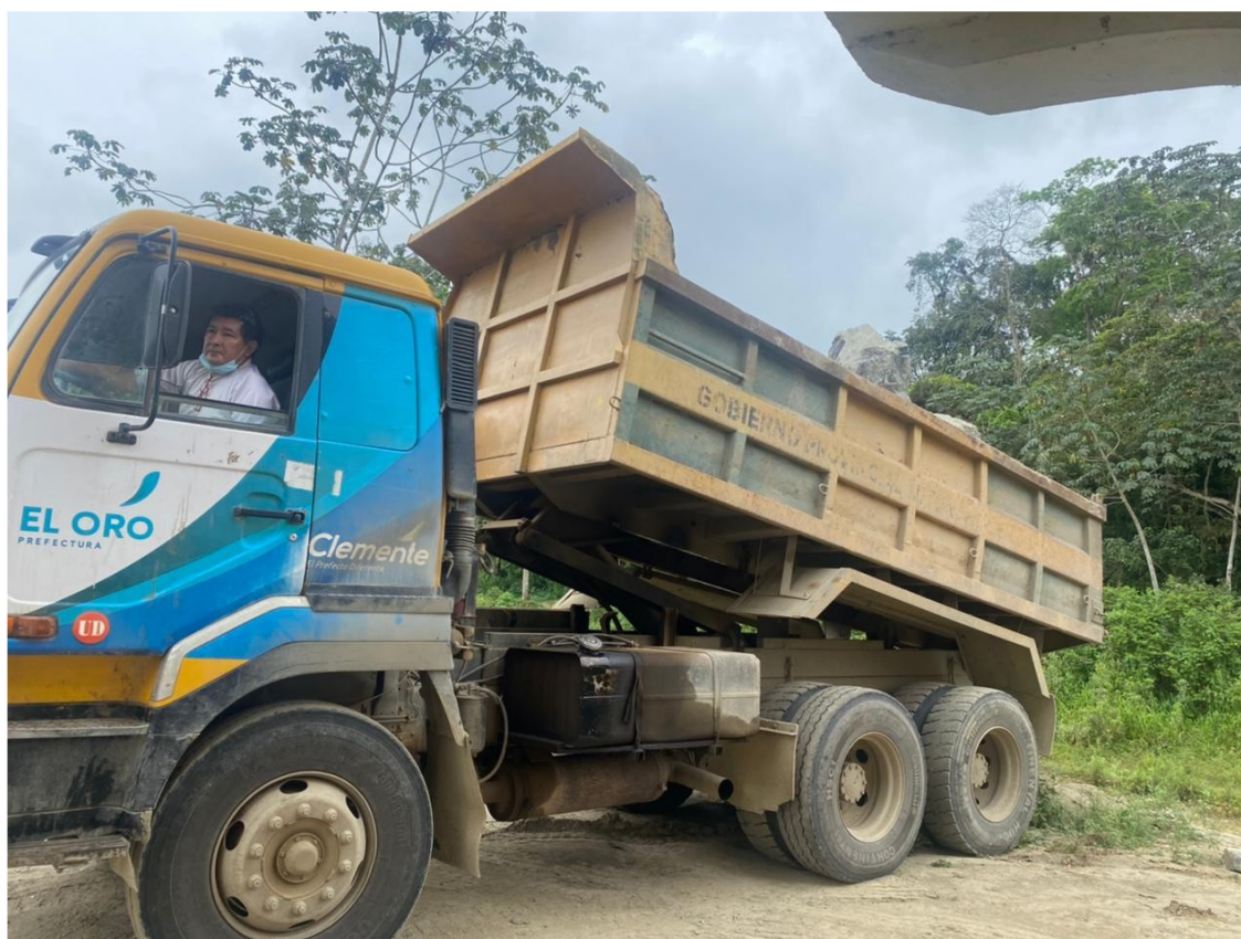
Verificando el material de escollera del jobo.
