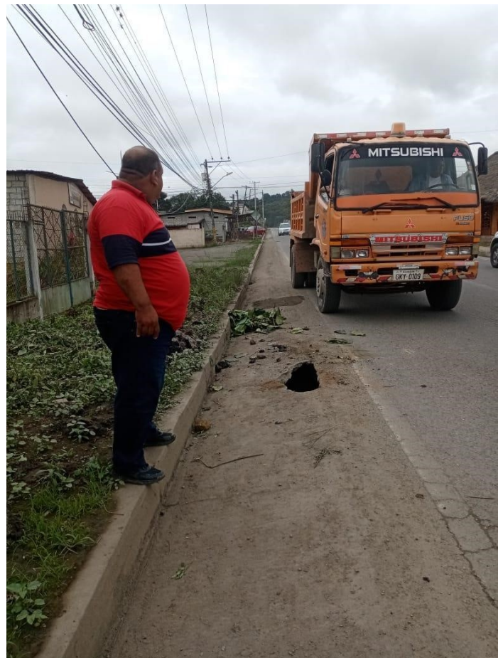
Haciendo un recorrido en la piscina de oxidación para posteriormente dar mantenimiento.
