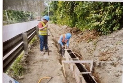
EXCAVACION PARA CONSTRUCCION DE BORDILLOS TRAMO #2
