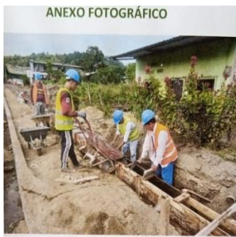
FUNDICION DE BORDILLOS-TRAMO #1
