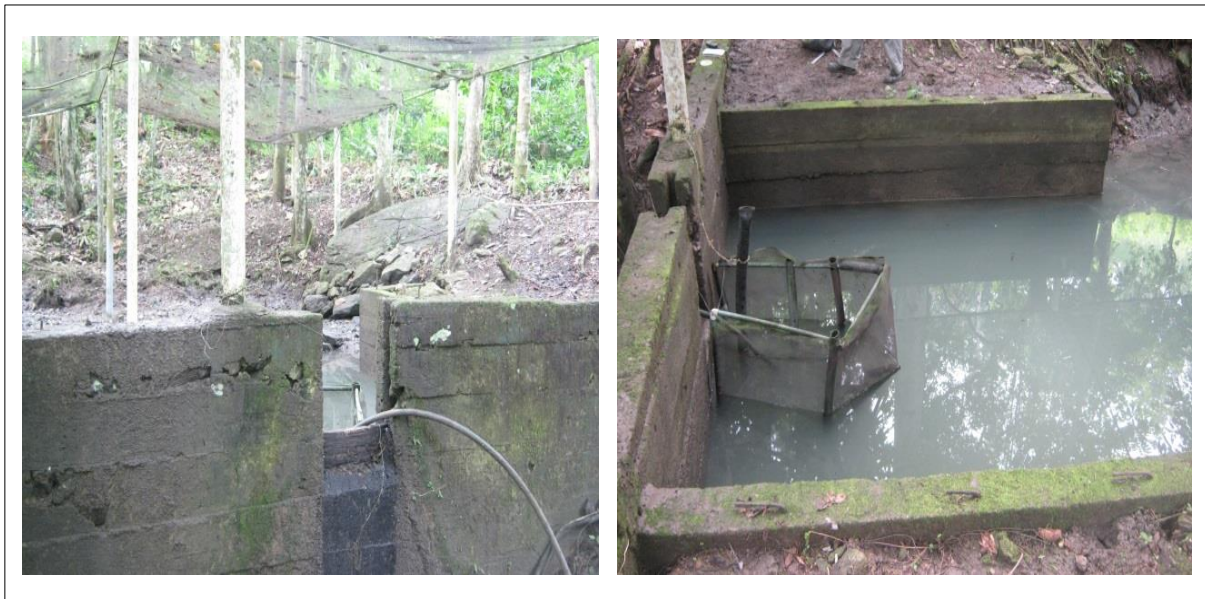
Figura 14.- Captación de Agua para Uso Doméstico La Pereira
