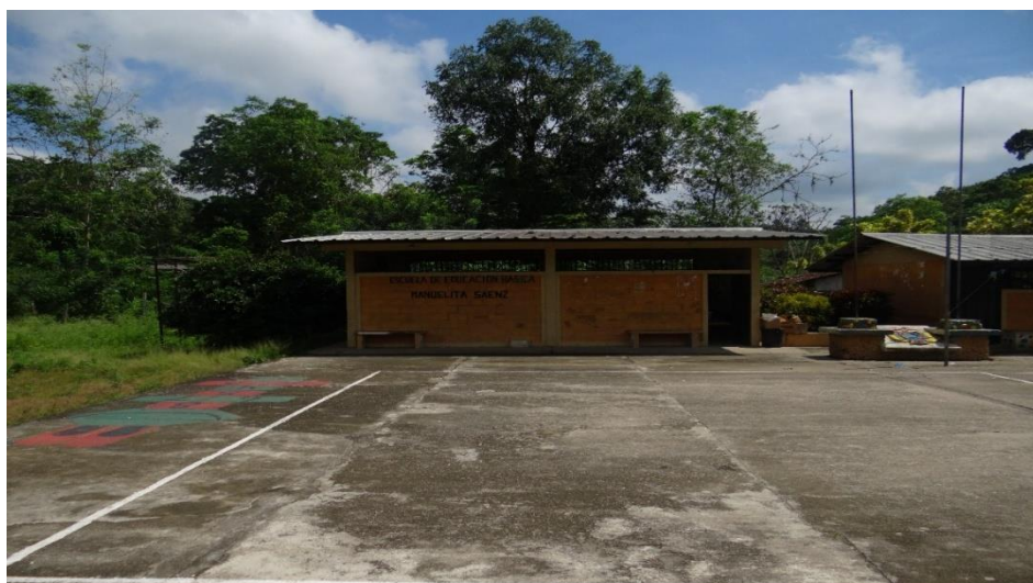
Figura 53. Cancha múltiple de la escuela Manuela Sáez Fuente: Equipo Consultor
